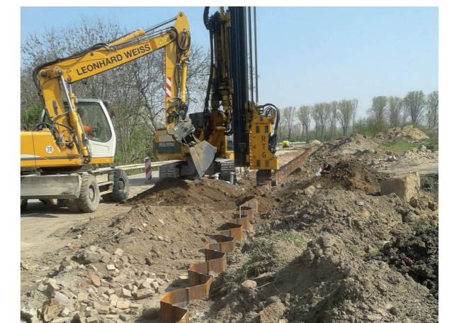
Spundwandarbeiten (Nordabschnitt).
